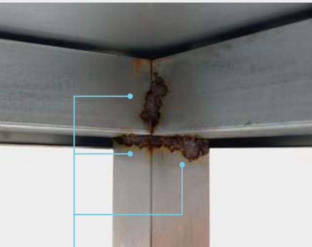
Oxydation par soudage
